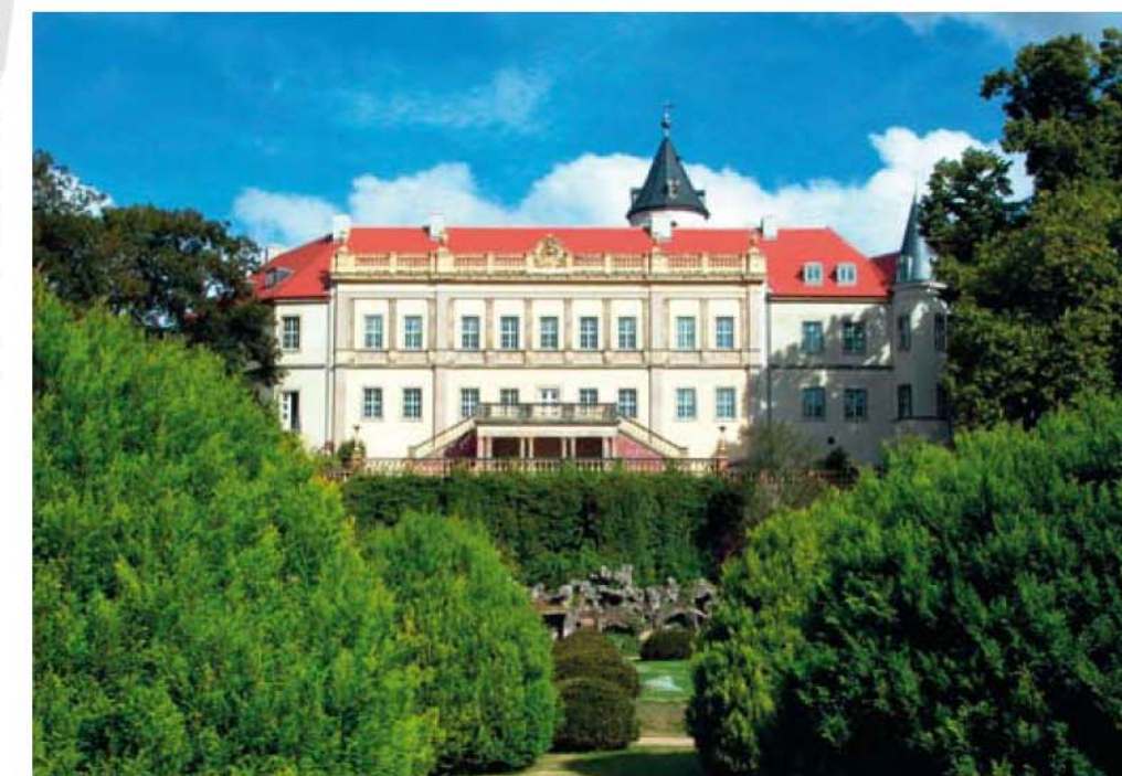
Südfassade von Schloss Wiesenburg
